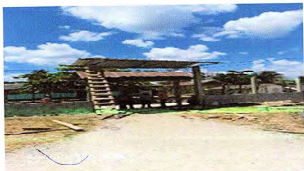
Foto1: Aquí se observa cuando el trabajador del techo del porton estaba instalando.
