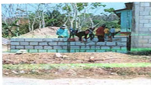
Foto 3: Se observa que en el lado Este, del establecimiento los señores están pegando los bloks
